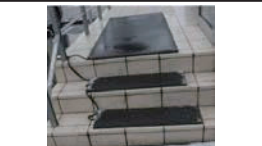
従業員通路への凍結防止装置の導入
